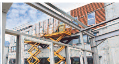
Bâtiment Corys T.E.S.S., en cours de construction.
